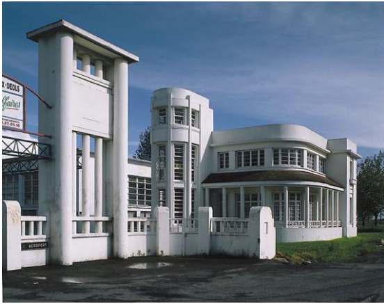
Entrée principale de l'ancienne usine d'aviation Marcel Bloch à Déols (Indre) Cl. Mariusz Hermanowicz, 2004
